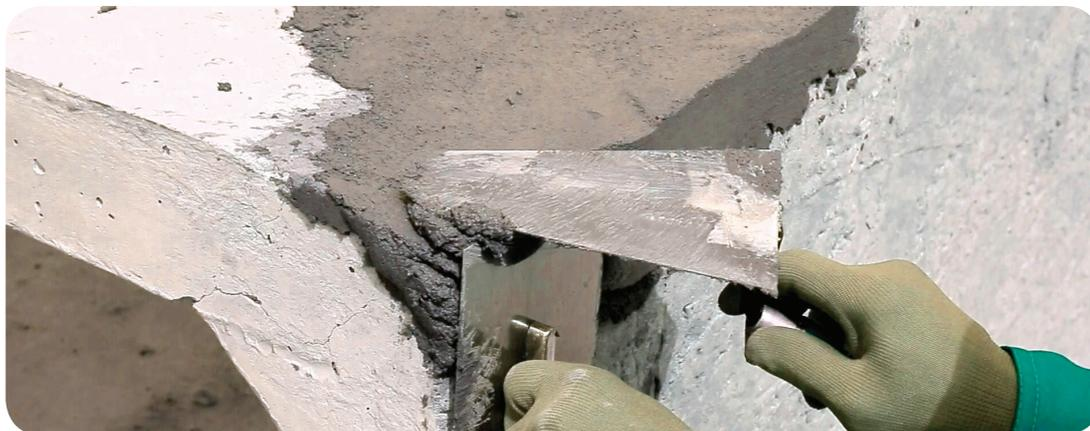
влажное основание, а затем постепенно нанести желаемую толщину. При ручном способе нанесения раствор наносится слоем в пределах указанного диапазона, от 3 до 40 мм, кистью или шпателем. Минимальная прочность, достаточная для ходьбы по поверхности, достигается через 3 часа. В процессе работы и в последующие два дня температура воздуха и поверхности основания должна быть не ниже +5°C и не выше +30°C, влажность воздуха в помещении не должна превышать 70%.
